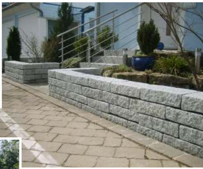
Trockenmauer aus Granitpalisaden
