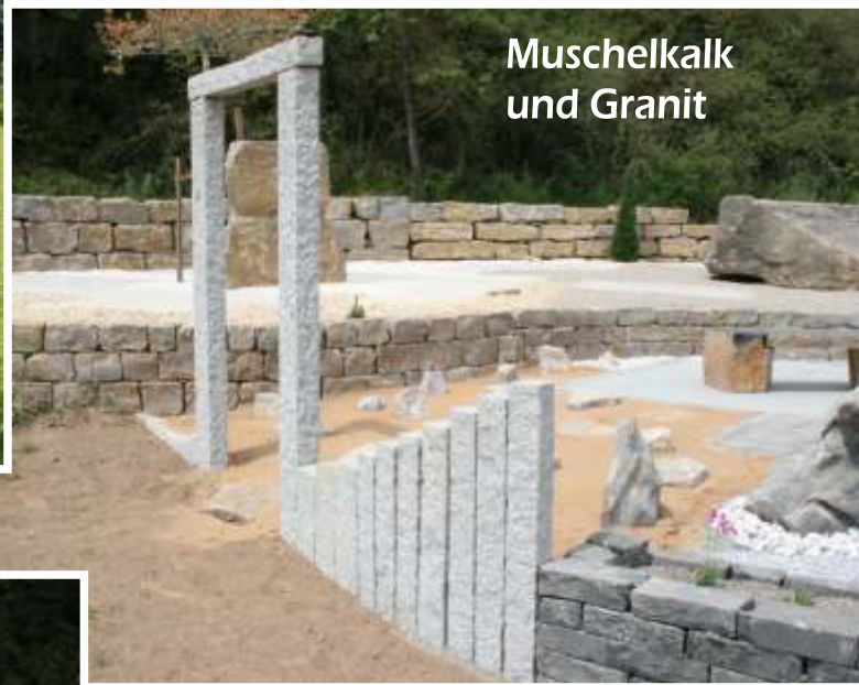
Trockenmauer aus Granitpalisaden
