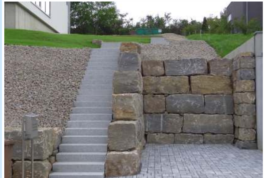
Trockenmauer aus Muschelkalk mit Granitblockstufen
