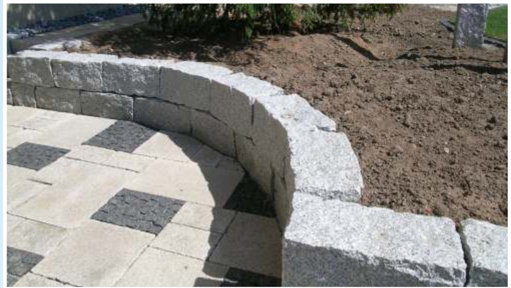
Trockenmauer aus Granit und Granitpflasterplatten
