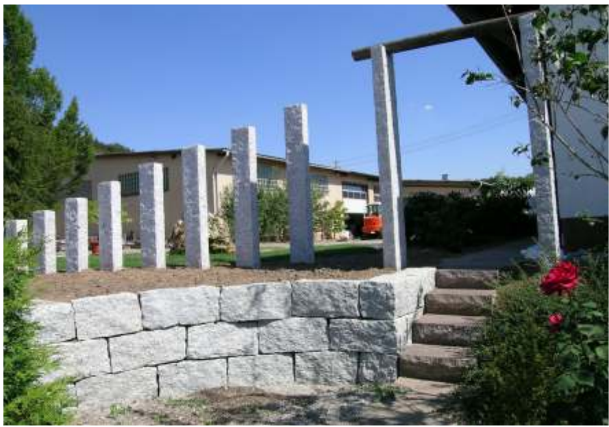
Trockenmauer und Palisaden aus Granit
