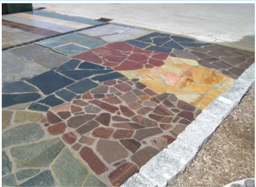
Polygonalplatten und Bahnenware aus verschiedenen Materialien
