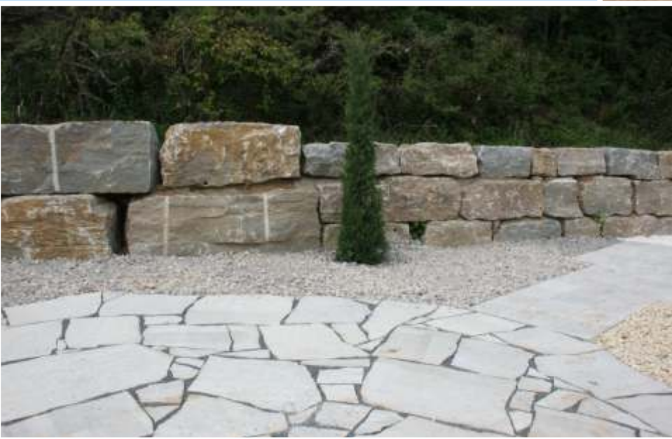
Trockenmauer und Bodenbelag aus Muschelkalk
